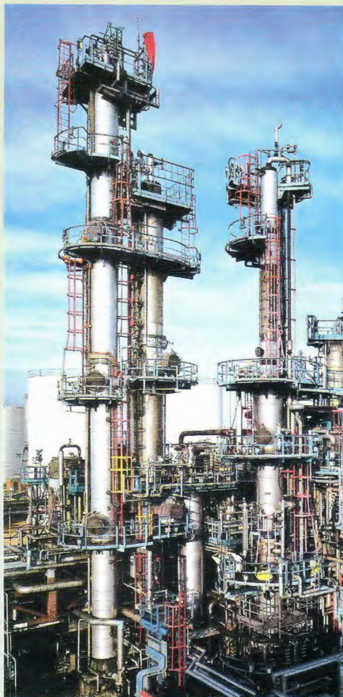
Proyecto en ejecución de la planta de LNG de Pampa Melchorita, a 169 Km. al sur de Lima
