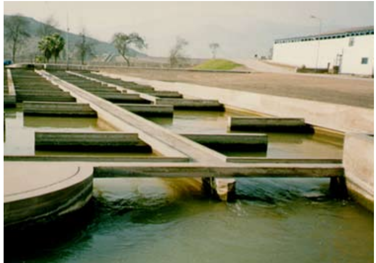
Figura 3. Esquema y batería de dos floculadores hidráulicos en la planta de tratamiento de aguas, evaluado con técnicas de trazadores.
