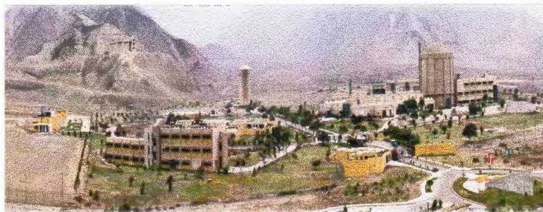
Figura 6: Foto panorámica del Centro Nuclear “RACSO” del IPEN.
