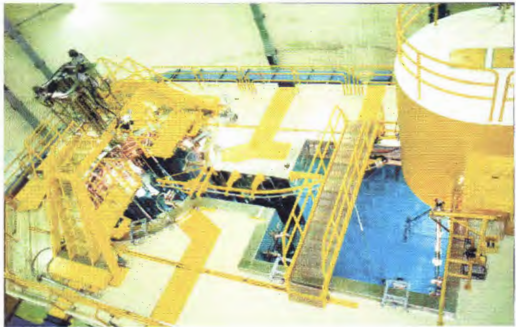
Figura 10: Vista Superior del Tanque Principal y Piletas Auxiliares del Reactor.
