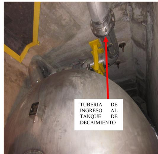
**Figura 2.** Detalle de la tubería de ingreso al tanque de decaimiento.
