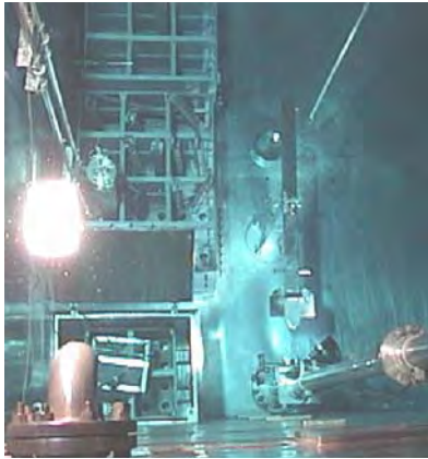
Pileta Auxiliar del Reactor RP-10.
