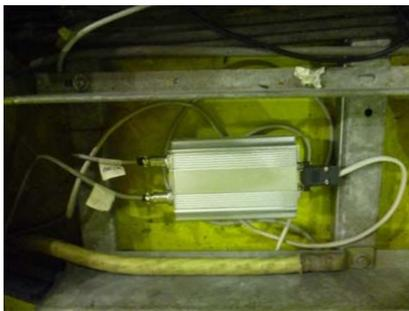
**Figura 4.** Imagen mostrando la instalación en la bandeja de cables del módulo controlador remoto.
