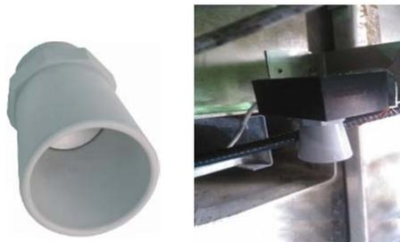
**Figura 1.** Sensor ultrasónico y su instalación en boca de tanque del reactor RP-10.
