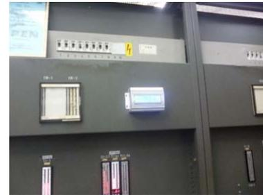
**Figura 5.** Arriba: Módulo controlador local, display LCD indica nivel de agua y tasa de exposición gamma. Abajo: Vista del montaje del módulo controlador local sobre el rack de instrumentación convencional del reactor RP-10.
