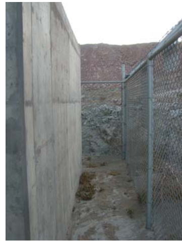
Figura 4. Pared lateral de almacén y cerco metálico perimétrico.
