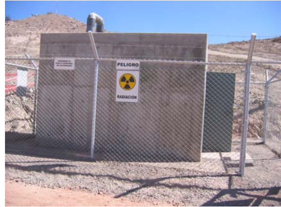
Figura 3. Vista lateral de almacén de fuentes radiactivas.
