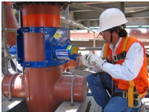
Figura 1. Operación de mantenimiento preventivo.
