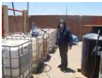
Figura 1. Tanques de lixiviados.
