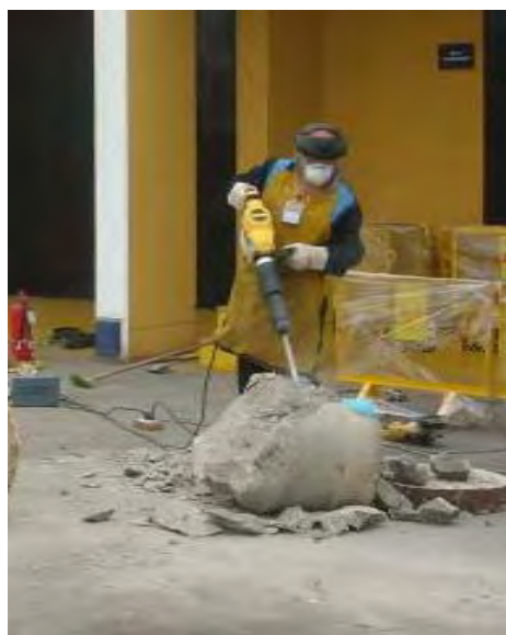
Figura 3. Retirando el material de cemento con indumentaria de seguridad.
