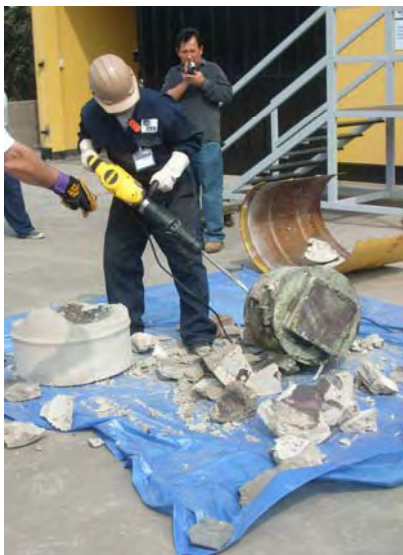
Figura 4. Colocación de cobertura plástica para recojo de material cementado.
