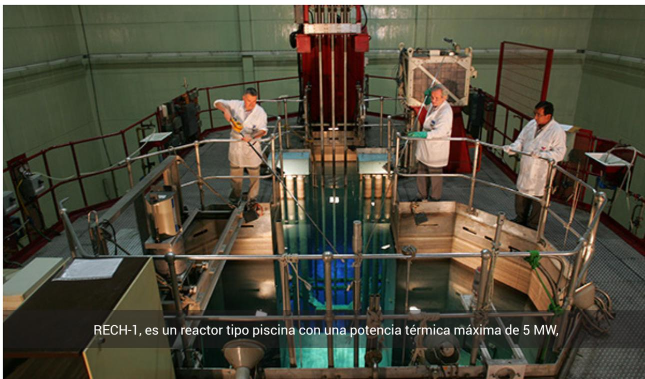
RECH-1, es un reactor tipo piscina con una potencia térmica máxima de 5 MW,
