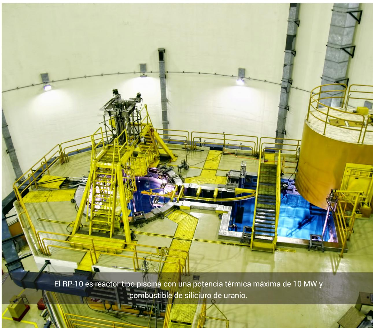
El RP-10 es reactor tipo piscina con una potencia térmica máxima de 10 MW y combustible de siliciuro de uranio.
